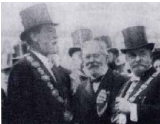
Wilhelm Exner zwischen Bürgermeister Dr. LUEGER und Vizebürgermeister HIERHAMMER bei der Grundsteinlegung des Technischen Museums 1909
